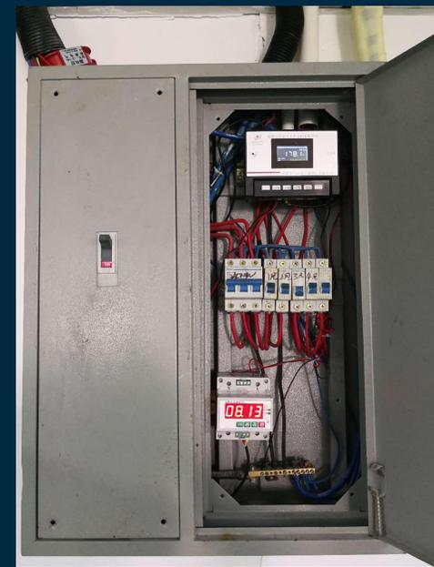
为进校园水泵房，安装水压变送器、水浸变送器、水位变送器、温湿度传感器、烟雾探测器，实时监测水泵房运行状态。
